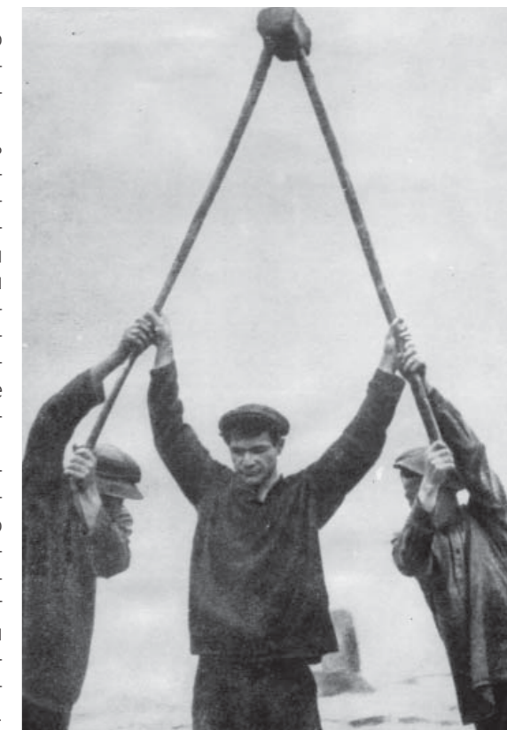
На стройке много работы приходилось делать вручную
