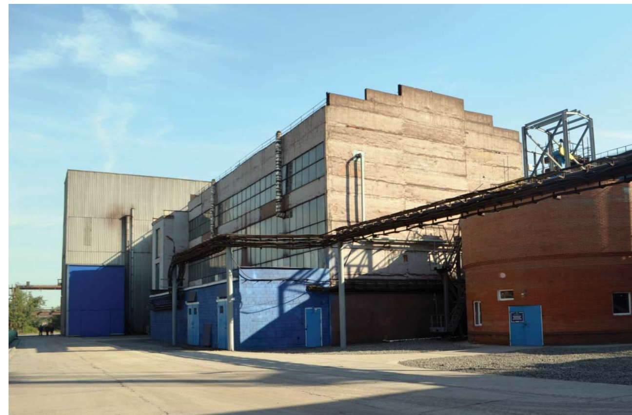
В 2014 году на заводе были введены в эксплуатацию локальные очистные сооружения хозяйственно-бытовых стоков
