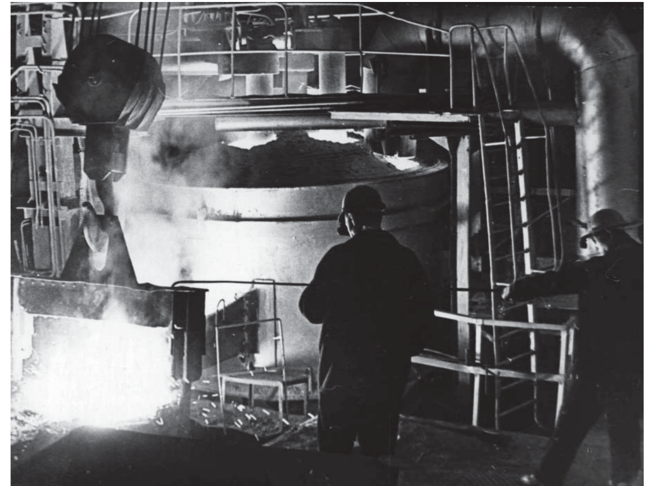
Вид плавильной печи научно-производственного объединения Тулачермет Фото: Центр новейшей истории Тульской области
