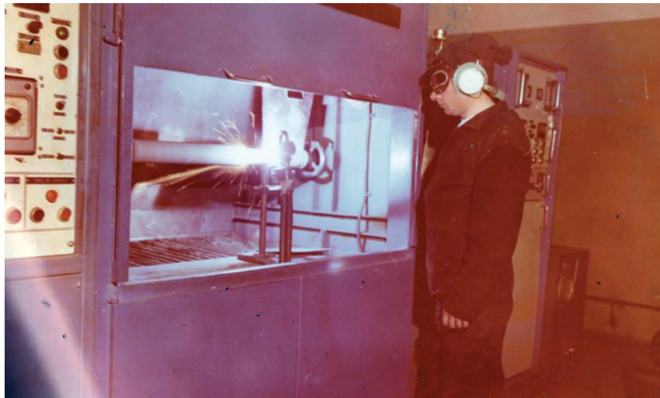
Электроискровая металлизация
