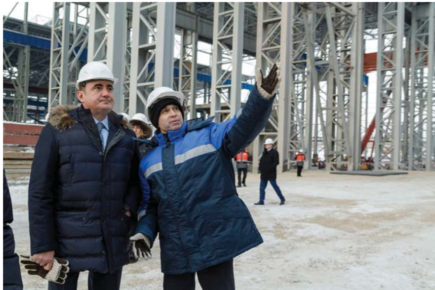
Губернатор Тульской области А. Дюмин осматривает строительство
