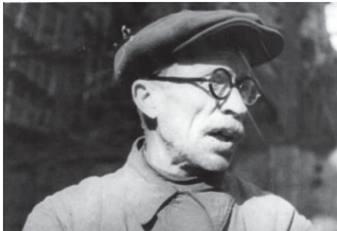
Первостроитель Потемкин на строительстве первой доменной печи
