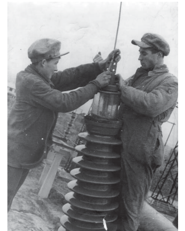
1934 год. Сборка трансформатора
