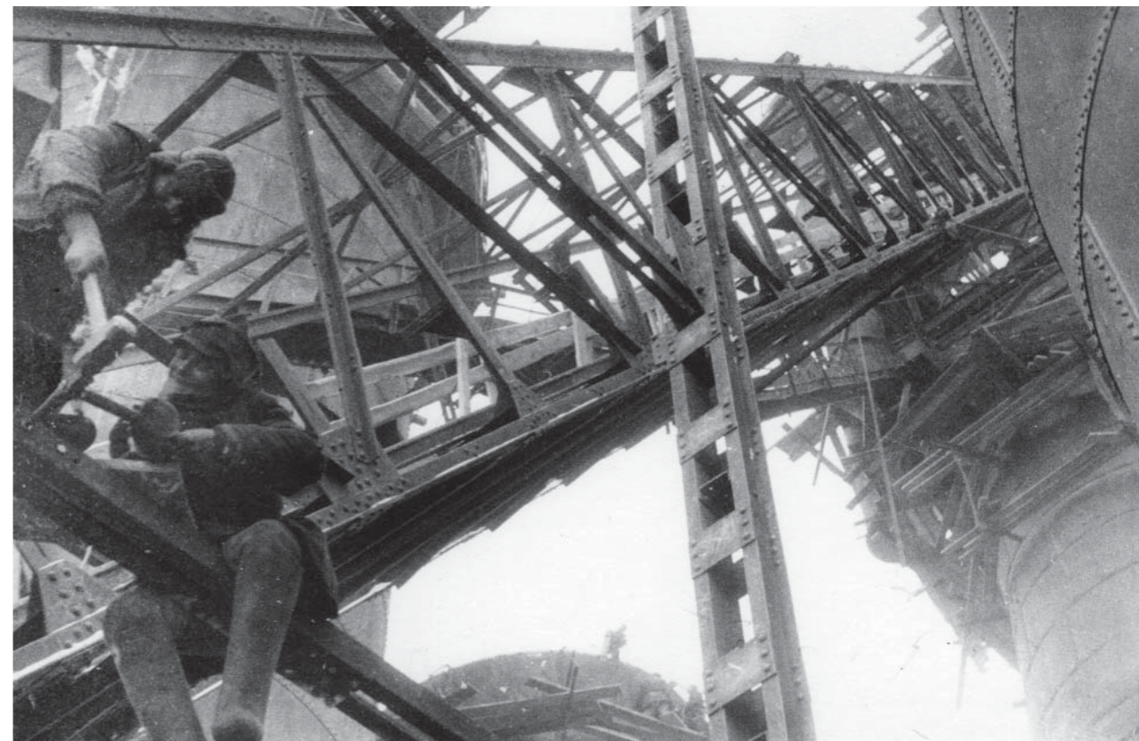
1932 год. Законченный наклонный мост доменной печи № 1
