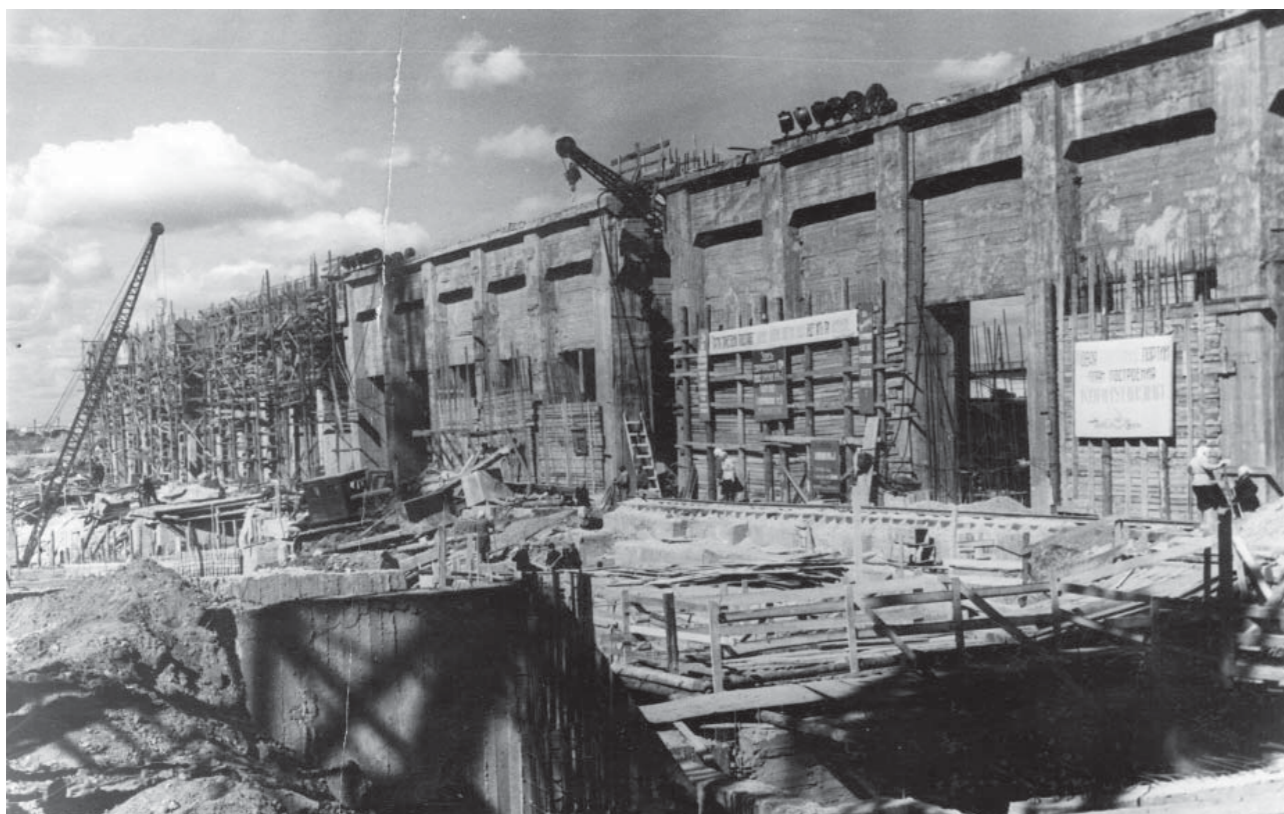
1934 год. Строительство консольного пути НТМЗ
