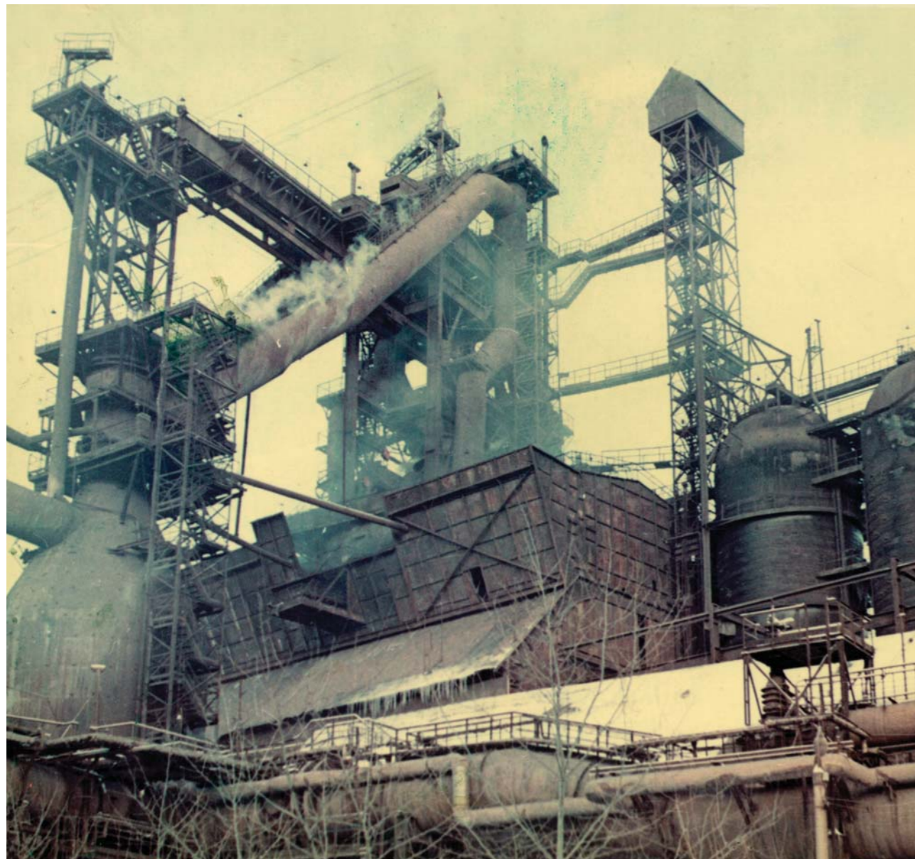
Новая доменная печь № 3 объем 2000 кубометров
