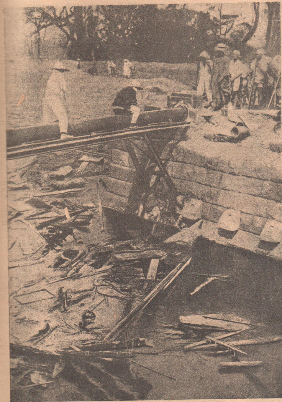
Работы по восстановлению засыпанного обвалившимися постройками канала Цукуи.
