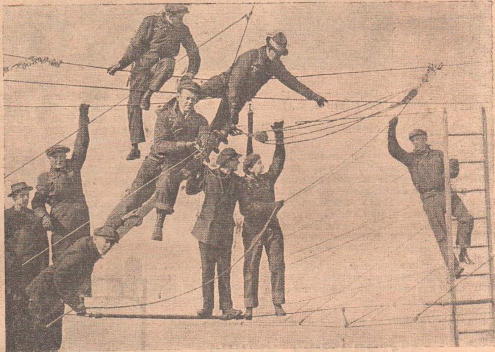
Электрификация дороги. Рабочие производят ремонт проводов.
