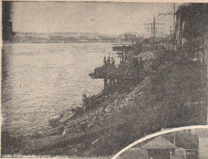
Ремонт Полыстровской набережной. Материал идет с разрушенных домов.
