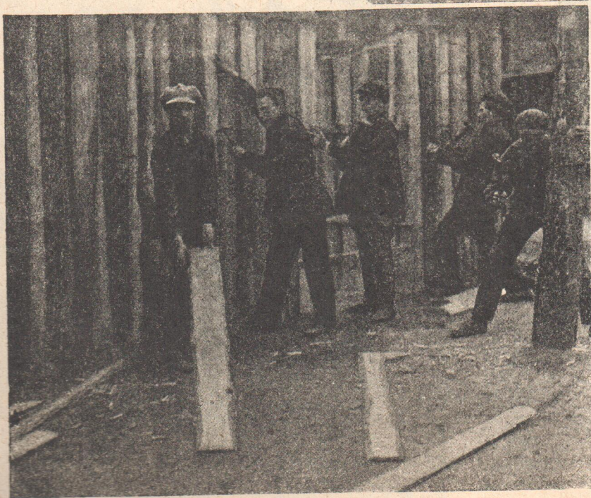
Опыты Института Труда—столярная бригада за стройкой забора.
