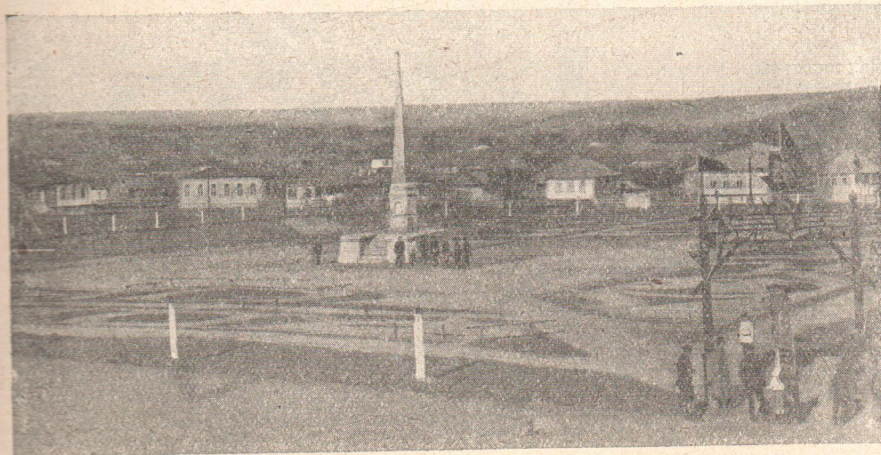
На ст. Глубокой, Юго-Восточной ж. д., силами рабочих, в течение 2 недель, сооружен бетонный обелиск-памятник вождю трудящихся В. И. Ленину. Высота обелиска 7 саж., в основании 3 кв. сажени. Вокруг обелиска разбит сад. Отсутствие воды для орошений цветочных клумб и плодовых деревьев не остановило рабочих. Была прорыта канава в 300 саж., проложены трубы и прежняя базарная площадь превращена в цветущий уголок.
