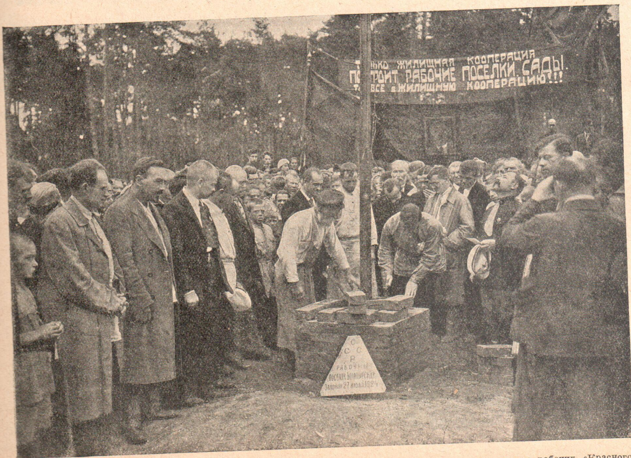
27 июля в подмосковном селе Богородском, за Сокольниками, жилищно-строительным кооперативом рабочих «Красного Богатыря» произведена торжественная закладка рабочего поселка, рассчитанного на 10—70 домов. В каждом доме будет по 3—4 квартиры. Слева стоит секретарь МК РКП тов. Антипов (X).
